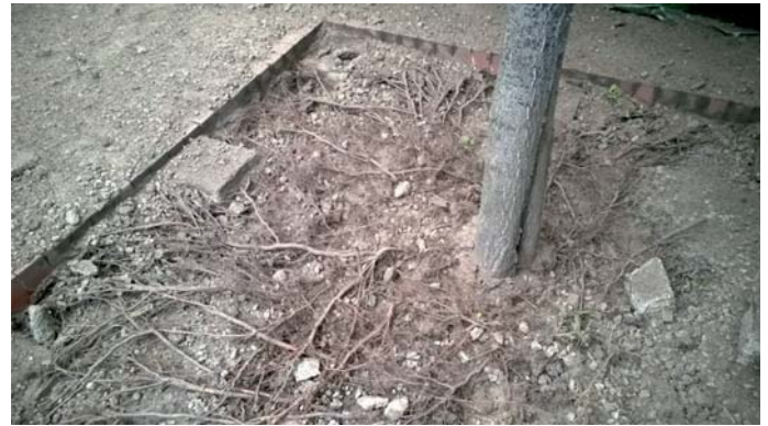
Fot. 1. System korzeniowy drzewa rozwinięty w misie chodnikowej – korzenie nie wydostały się poza obręb misy (fot. Podgórska)
