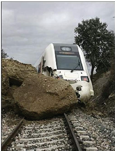
Fot. 1. Wypadek spowodowany aktywacją osuwiska w Hiszpanii w 2010 roku [10]
