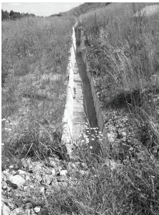
Fot. 4. Koryto odwiadniające z prefabrykatów betonowych
