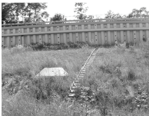
Fot. 3. Osuwisko w Sadowiu- zabezpieczenie larsenami oraz studnie odprowadzające wodę z drenażu
