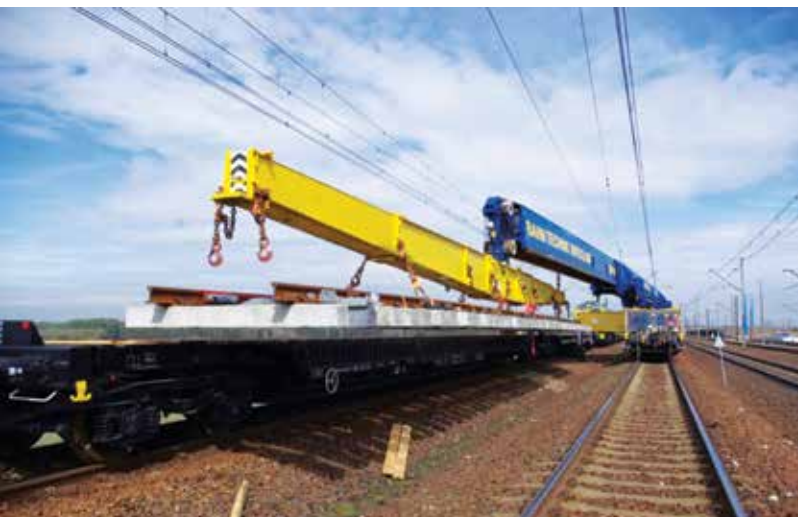
Fot. 4. Specjalistyczny żuraw kolejowy Gottwald GS 150.14TR podczas zabudowy rozjazdu na stacji Psary Źródło: archiwum własne.
