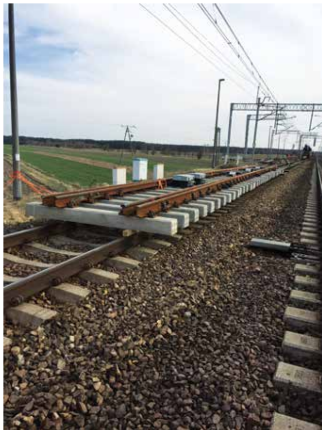
Fot. 3. Przygotowany do zabudowy blok zwrotnicy Źródło: archiwum własne.
