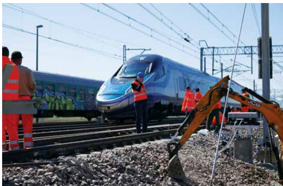
Fot. 5. Prace przy montażu rozjazdu Źródło: archiwum własne.
