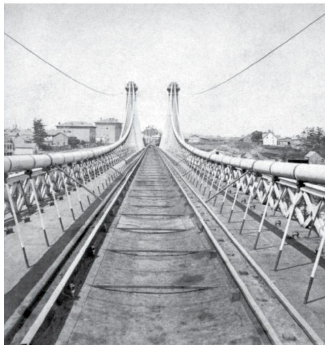
Il. 2. Tor czteroszynowy na Niagara Suspension Bridge z 1855 r. służył pociągom New York & Erie RR – 1829 mm, kanadyjskiej Great Western Rly. – 1676 mm oraz New York Central RR – 1435 mm. fot. J. P. Soule, ~1857, kol.: NY Public Library, Robert Dennis Collection; WikiComm, PD
