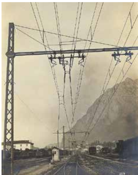
Il. 4. Elektryfikacja trójfazowa na stacji Lecco w Lombardii fot. nieznanymi, ~1910, kol.: ETH-Bibliothek Zürich, Bildarchiv; WikiComm, PD
