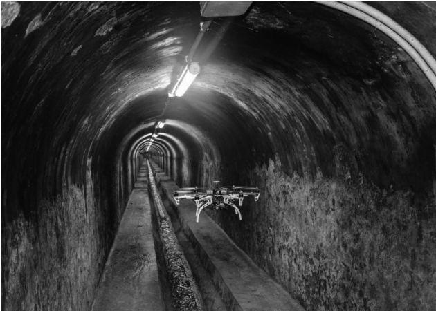
Fot. 8. Projekt monitorowania sieci kanałów w Barcelonie (źródło: http://www.greentechbarcelona.com/es/proyectos-destacados/proyecto/43 )
