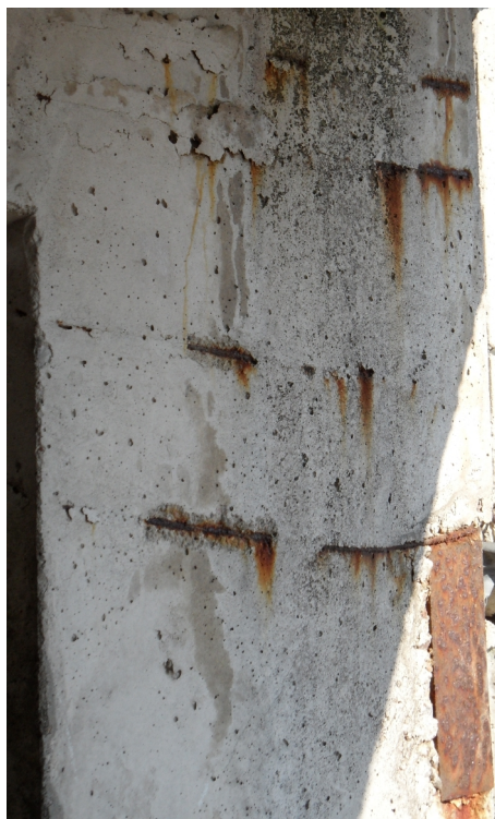
Rys. 8. Widok wewnętrznej ściany budynku wielkopłytkowego, autor: D. Tomaszewicz
