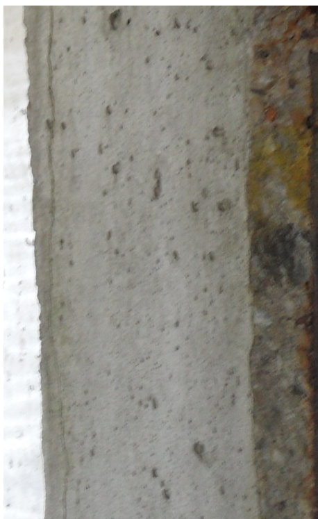
Rys. 9. Widok ściany wewnętrznej w otworze drzwiowym, autor: D. Tomaszewicz
