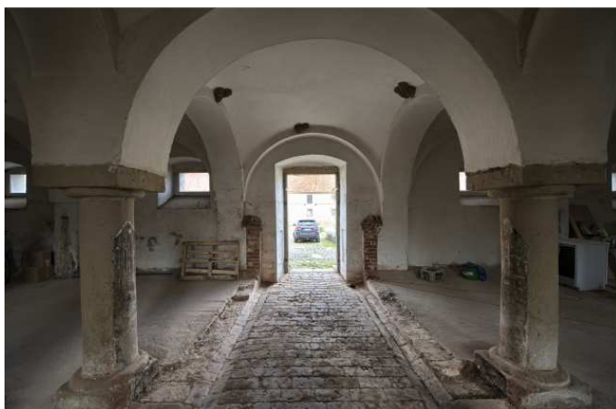
Rys. 4. Wnętrze budynku, fot. A. Władyka, Maj 2017
