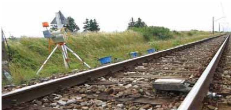
Fot. 6. Ustawienie kablowych sygnalizatorów akustyczno-optycznych oraz zamontowanie kontaktu szynowego
