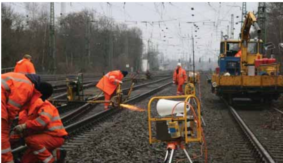
Fot. 2. Plac budowy z zastosowaniem Mobilnego Systemu Ostrzegania [5]
