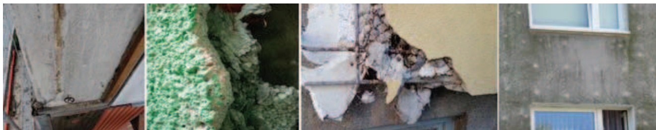
Rys. 5. Technologie dociepleń budynków stosowane w ubiegłych latach i obecnie: a) lekka sucha, b) ciężka mokra, c) ciężka mokra, d) lekka mokra (aktualnie stosowana)
