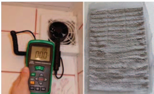
Rys. 10. Przyczyny braku lub ograniczonej wymiany powietrza wewnątrz budynków: a) wentylator uruchamiany wraz z oświetleniem, b) nieczyszczona kratka wentylacyjna (widok od wnętrza komina)
