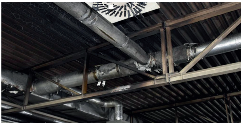
Rys. 1. Wnętrze obiektu z dźwigarem kratowym
