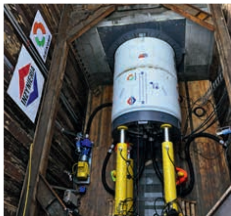
Montaż tarczy drążącej kolektor Burakowski-Bis, fot. Archiwum MPWiK
