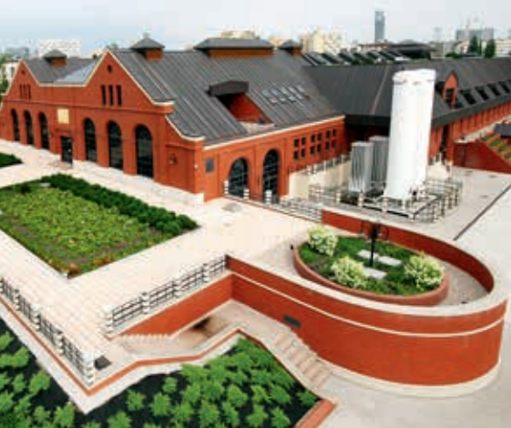
Stacja ozonowania pośredniego i filtracji na węglu aktywnym na terenie SUW „Filtry”, fot. Studio Awokado
