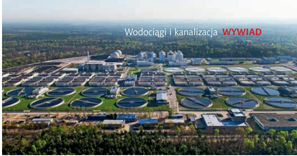
Panorama Oczyszczalni Ścieków „Czajka”, fot. Kacper Kowalski/aeromedia.pl
