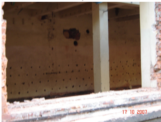
Zdj. 1. Budynek nitracji: a) widok ogólny; b) ściana budynku nitracji z otworami na ładunki burzące
