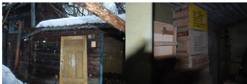
Zdj. 3. Budynek produkcyjny na terenie Zakładu „Pronit”: a) widok zewnętrzny, b) wnętrze z pozostawionymi opakowaniami transportowymi po materiałach wybuchowych
