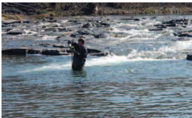
Rys. 2. Bystrze na potoku Porębianska; należy zwrócić uwagę na koncentrację przepływu na płycie spadowej bystrza, zapewniające przechodzenie ryb nawet przy niskich stanach wody (fot. A. Radecki-Pawlik)
