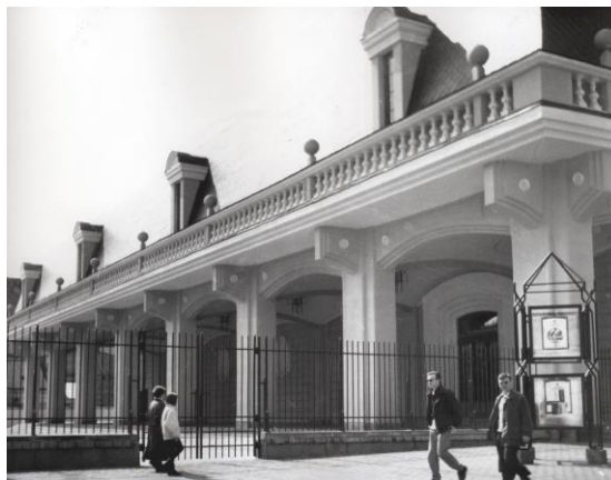
Rys. 8. Pałac Sztuki. Fragment elewacji Źródło: fotografia autora (1997 r.)
