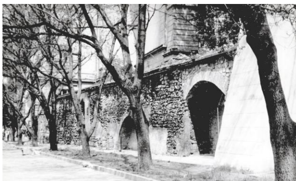
Rys. 4. Odsłonięty fragment muru obronnego z XVII wieku Źródło: fotografia autora (1960 r.)
