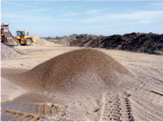
Fot. 9. Zasobnik żwiru frakcji 2 - 8 mm – widok boczny Photo 9. Storage tank of gravel's fraction 2-8 mm – side view
