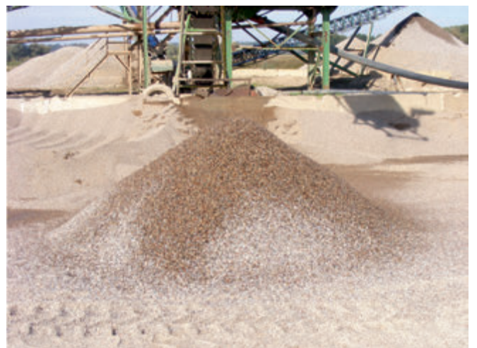
Fot. 8. Zasobnik żwiru frakcji 2 - 8 mm – widok na czoło Photo 8. Storage tank of gravel's fraction 2 - 8 mm – front view
