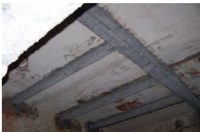
Rys. 17. Strop ceramiczny wzmocnione przy użyciu kształtowników stalowych, fot. J. Misiewicz, 2007
