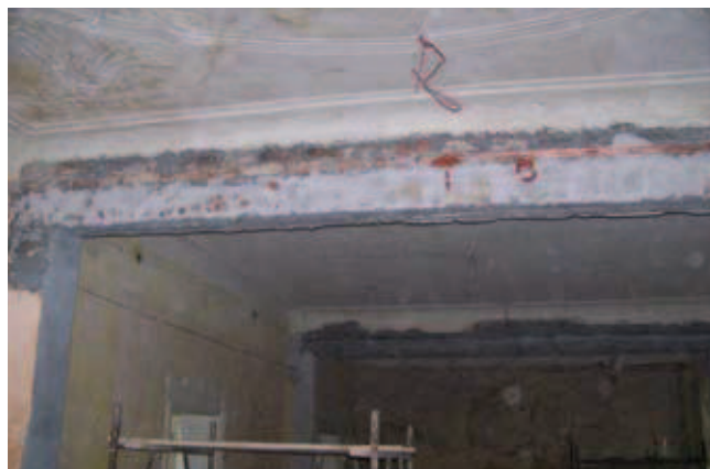
Rys. 16. Żelbetowy podciąg w miejscu wyburzonej ściany nośnej, fot. J. Misiewicz, 2007
