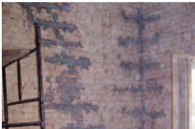
Rys. 15. Naprawy spękań muru, fot. J. Misiewicz, 2007
