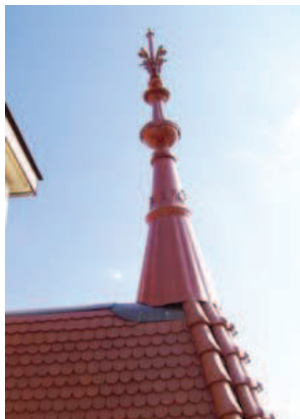
Rys. 20, 21. Dachy pokryte dachówką karpiówką, fot. J. Misiewicz, 2008
