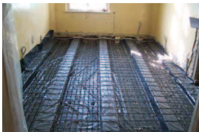
Rys. 18. Prace wzmocniające stropu drewnianego, fot. J. Misiewicz, 2007
