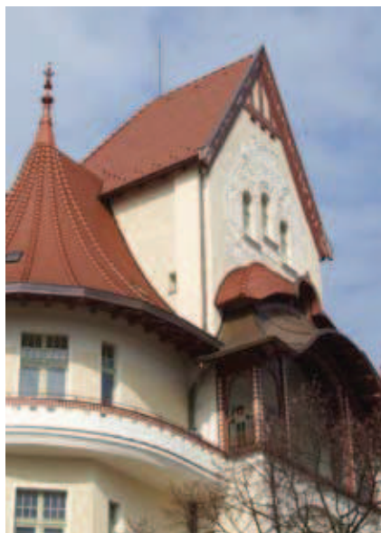
Rys. 20, 21. Dachy pokryte dachówką karpiówką, fot. J. Misiewicz, 2008
