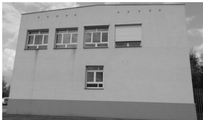
Rys. 5. Wschodnia strona budynku K Fig. 5. East side of building K
