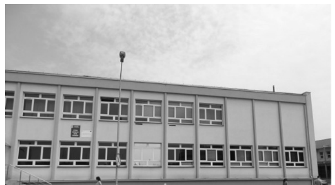
Rys. 4. Południowa strona budynku K Fig. 4. South side of building K
