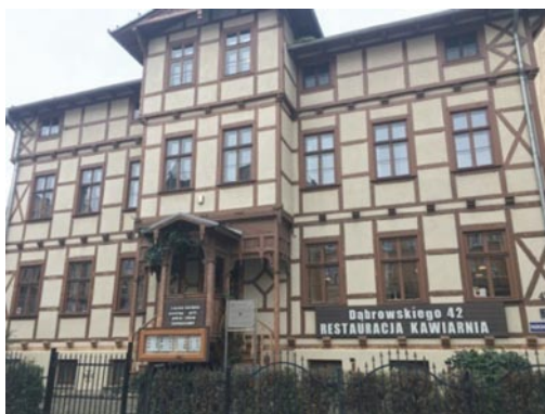
Rys. 2. Kamienica po remoncie – elewacja frontowa i tylna (fot. autora)
