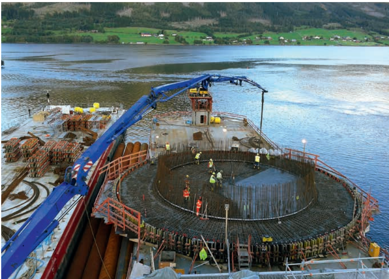
Ryc. 5. Betonowanie płyty dennej kesonu na barce
