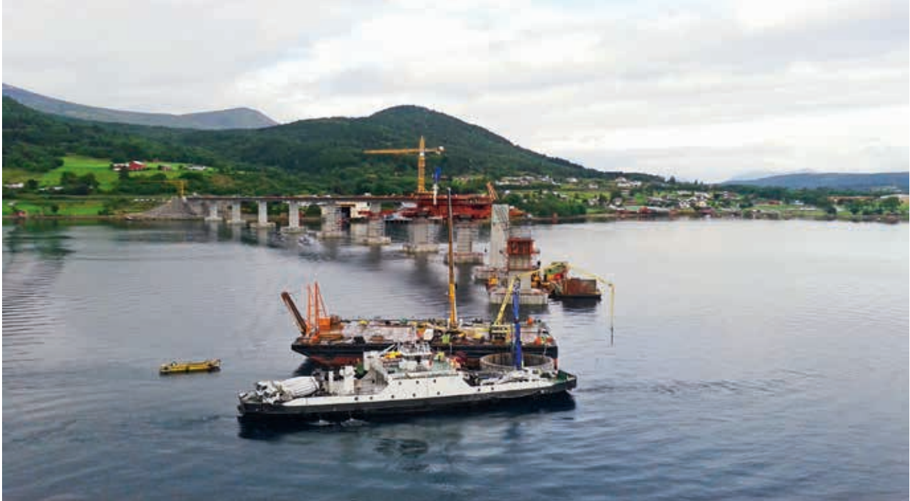
Ryc. 17. Betonowanie pod podstawą kesonu w osi 8
