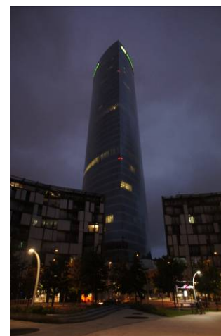
Fig. 7. Wieża Ibedroli. Źródło: autor
