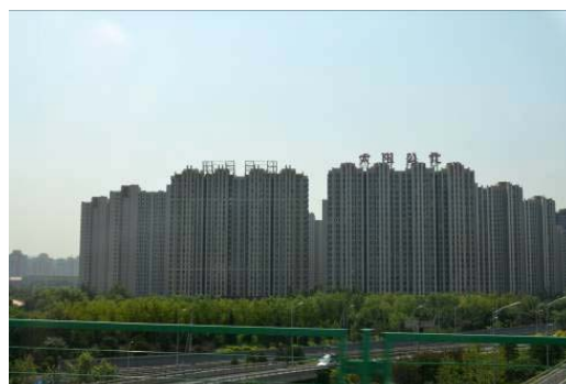
Ryc. 23 Masowe budownictwo mieszkaniowe w Pekinie, cechuje się dążeniem do ekstremalnej intensywności. W tym przypadku „trzeci modernizm” oznacza maksymalizację idei pionierów modernizmu, stymulowaną przez ustrój totalitarny. Źródło: Fot. autor
