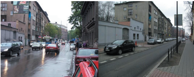
Fot. 1. Ulica Warszawska przed i po remoncie Źródło: zdjęcie ze zbiorów T. Kulpy
