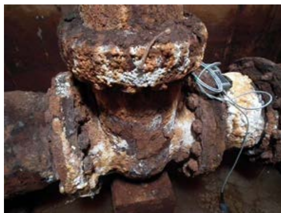
Ryc. 1. Wykwity solne w studni spustowej solanki (Krakowiak i in., 2013)
