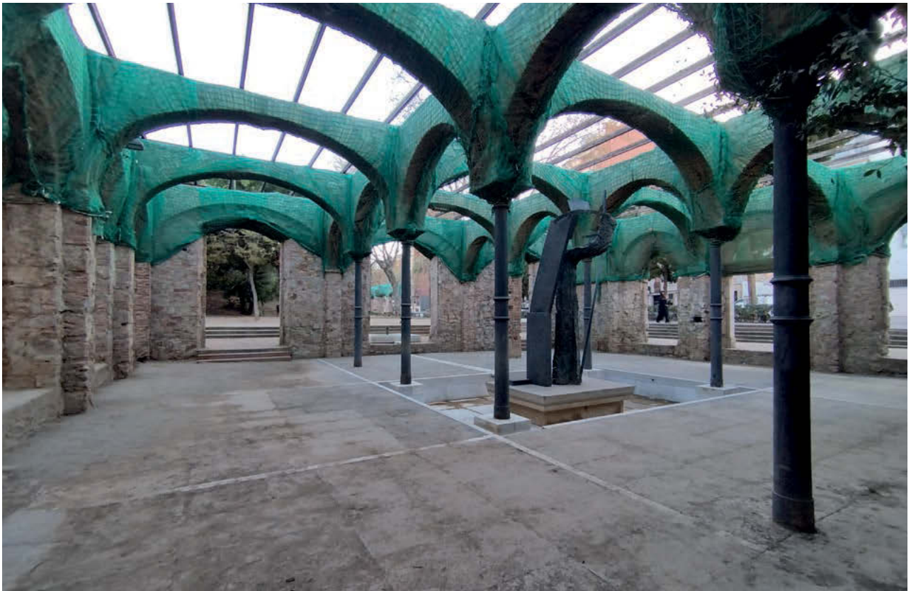
III. 9. Parc del Clot in Barcelona. Post-industrial relics protected by netting from spreading due to drought. Photo by K. Hofert. II. 9. Poprzemysłowe relikty zabezpieczone siatką przed rozsypaniem ze względu na suszę. Fot. K. Hofert.
