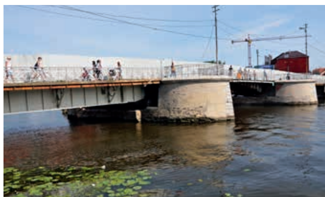
Poniewiecki drewniany most zwodzony przez Pregolę północną w Kaliningradzie (obiekt nr 55)
