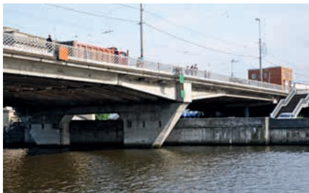
Betonowy most sprężony na Prospektie Lenina przez Pregolę północną w Kaliningradzie (obiekt nr 57)
