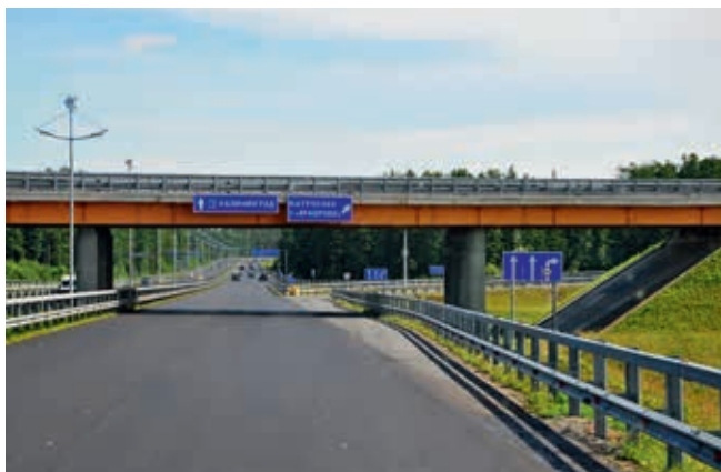
Stalowy wiadukt belkowy nad autostradą Zielenogorsk – Kaliningrad (obiekt nr 53)
