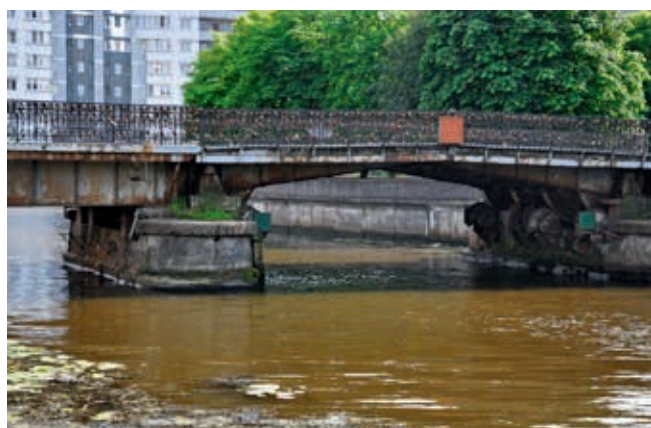
Poniewiecki most zwodzony Miodowego Miesiąca w Kaliningradzie (obiekt nr 56)
