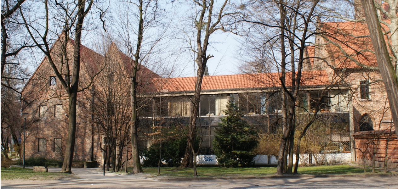
Il. 3. Skrzydło wschodnie dawnego klasztoru pobernardyńskiego, elewacja zewnętrzna, stan z 2015 r. (fot. E. Grodzka)
