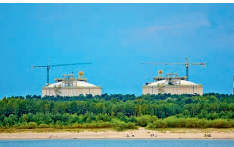
Początkowa zdolność regazyfikacyjna instalacji wyniesie 5 mld m 3 i odpowiadać będzie ok. 1/3 polskiego zapotrzebowania na gaz ziemny. Istnieje możliwość rozbudowy terminalu o kolejny, trzeci zbiornik do 7,5 mld m 3 rocznie
