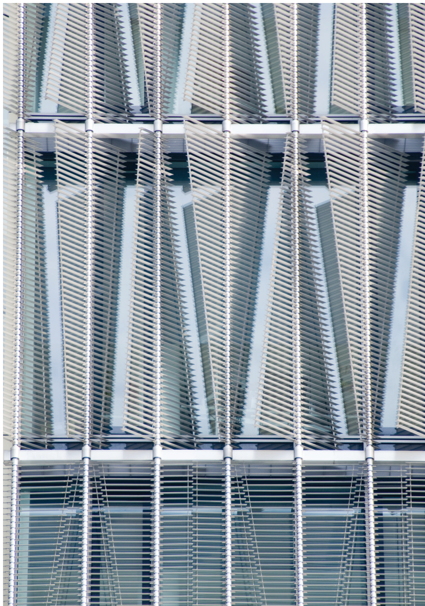
Rys. 1. Fasada budynku Q1 Thyssen-Krupp; źródło: fot. autora
