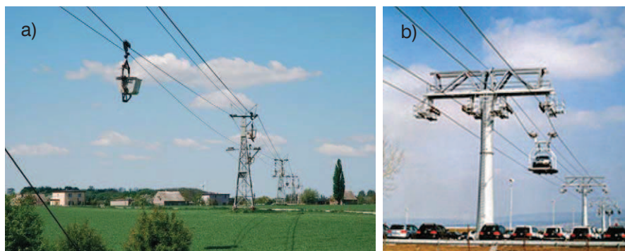
Rys. 11. Przykłady napowietrznych kolei liniowych do transportu: a) wapienia z kopalni w Piechcinie do zakładu produkcji cementu [7], b) samochodów osobowych w fabryce [8]
