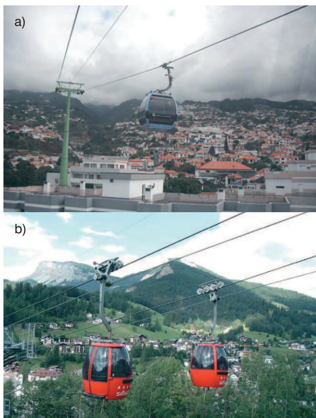
Rys. 12. Przykłady gondolowych kolei napowietrznych: a) kolej jednolinowa w Funchal, Madera (fot.M.K-H), b) kolej dwulinowa na Mont Seuc w Ortisei, Włochy [9]
