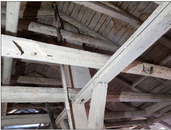
Ryc. 7. Wtórnie użyte elementy, widoczna jętką z gniazdami po złączach nakładkowych i znakiem montażowym w formie kresek przy krawędzi; fot. U. Schaaf 2021.
