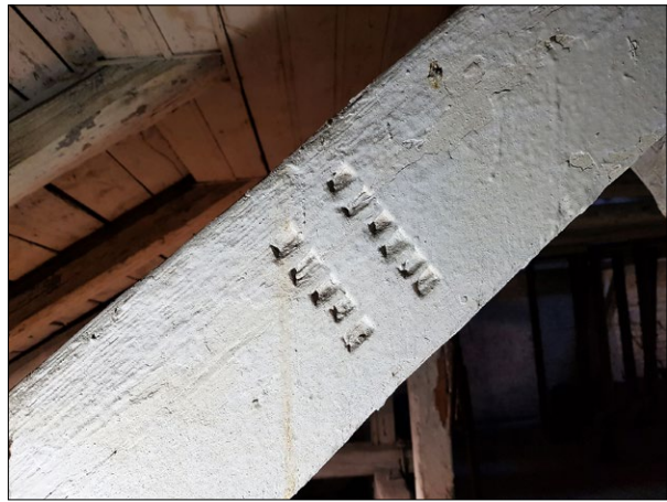
Ryc. 8. Wtórnie użyte elementy, fragment krokwi ze znakiem montażowym w formie kwadracików przy kresce; fot. U. Schaaf 2021.
