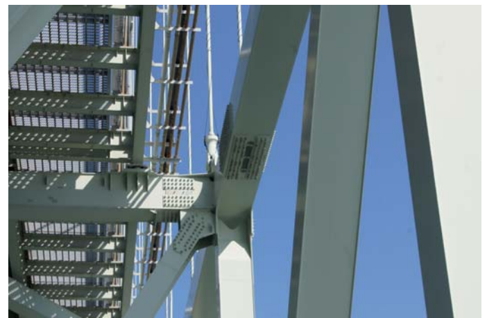
Fot. 12. Węzły prętów głównych i stężeń
