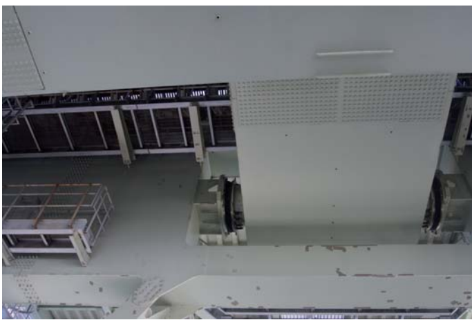
Fot. 15. Tłumiki poziomych drgań poprzecznych konstrukcji przęsła na podporze pylonowej
