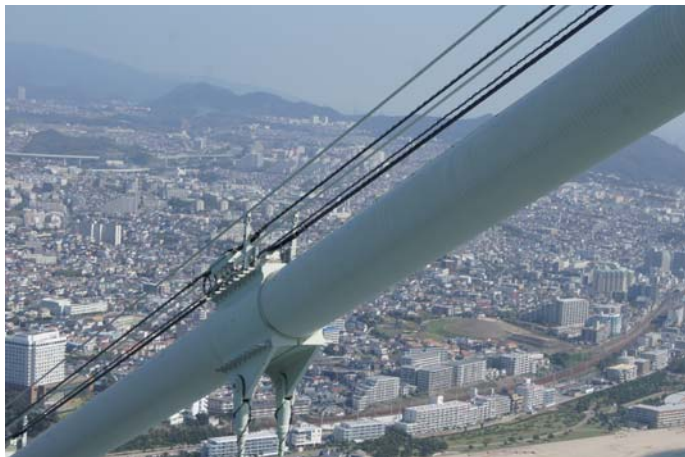
Fot. 19. Zamocowanie wieszaków do liny nośnej
