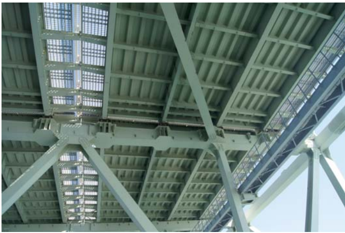
Fot. 14. Widok na uźebrowanie pomostu ortotropowego
