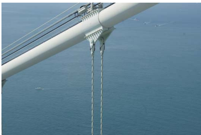
Fot. 20. Liny spiralne do tłumienia drgań wieszaków
