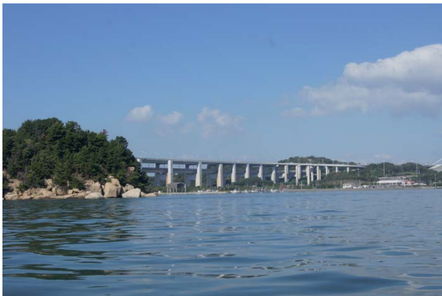
Fot. 3. Estakada z betonu sprężonego nad wyspą Hitsuishu w ciągu przeprawy Seto – Ohashi
