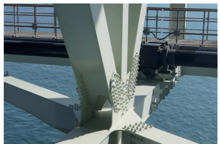
Fot. 13. Śrubowe połączenia prętów kratownicy przęsła
