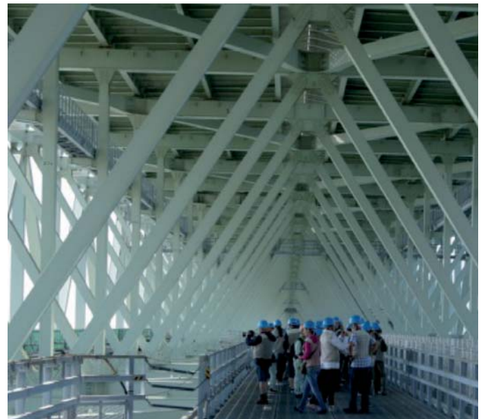
Fot. 11. Przejście robocze w poziomie dolnego pasa kratownicy przęsła
