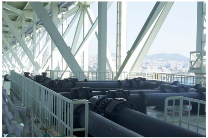
Fot. 17. Kompensacje rurociągów
