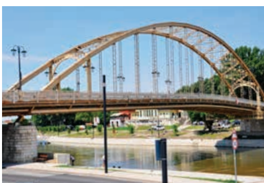
Stalowy most łukowy z jazdą dołem przez Dunaj Moszoński w Győr (obiekt nr 13)
