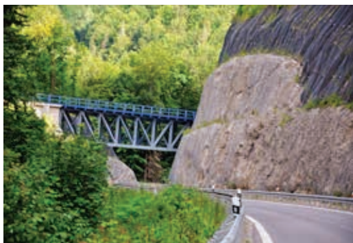
Stalowy wiadukt kolejowy nad drogą do Bańskiej Bystrzycy (obiekt nr 6)
