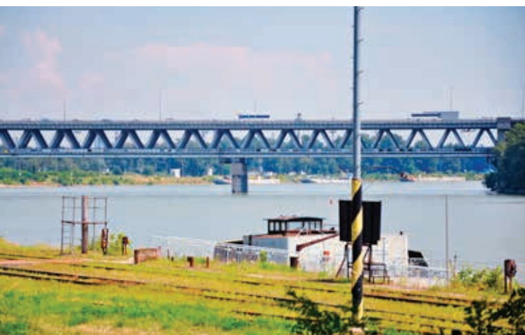
Stalowy most kratownicowy Bohaterów Dukli przez Dunaj w Bratisławie (obiekt nr 19)
