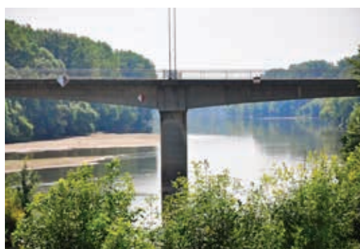
Czteroprzęsłowy, betonowy most sprężony przez Wąg w Kolárovice (obiekt nr 11)
