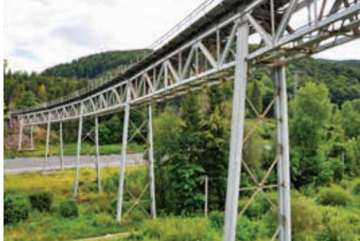
Wieloprzęsłowy, stalowy wiadukt kolejowy pod Dielom (obiekt nr 3)
