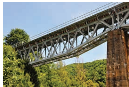
Stalowy most kolejowy na trasie Bańska Bystrzyca - Bańska Szczawnica (obiekt nr 7)
