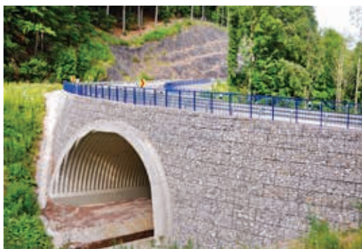
Przepust drogowy gruntowo-powłokowy na drodze do Bańskiej Bystrzycy (obiekt nr 5)
