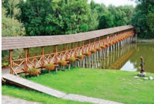
Drewniana kryta kładka dla pieszych przez Wąg w Kolárovice (obiekt nr 10)
