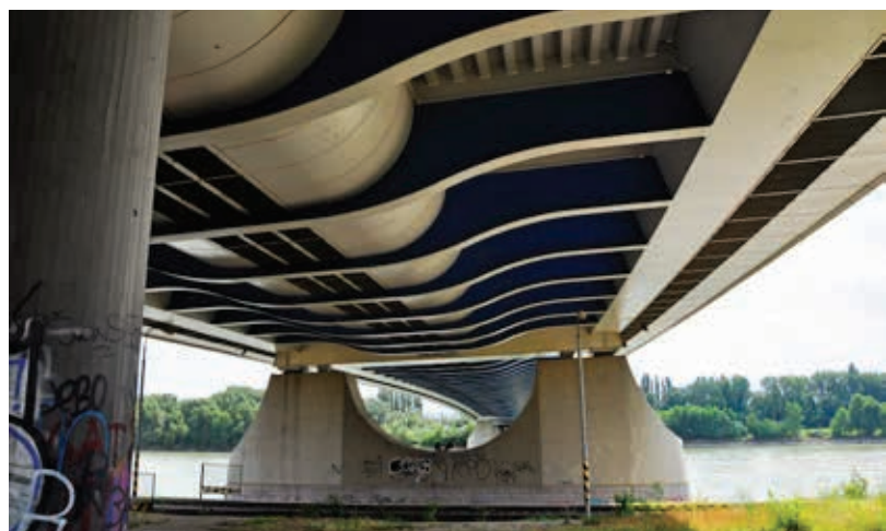
Widok od spodu przęsła mostu Apollo w Bratisławie
