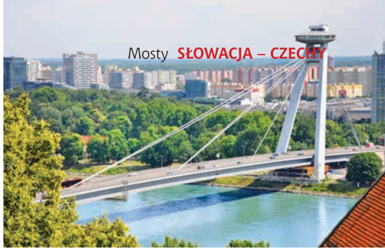
Widok mostu Nowego – stalowego podwieszonoego, jednopylonowego – ze wzgórza zamkowego w Bratysławie
