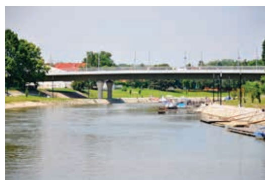
Betonowy most belkowy przez Rabę (dopływ Dunaju Moszońskiego) w Győr (obiekt nr 14)
