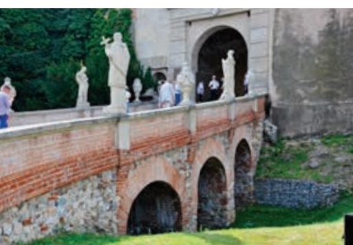
Łukowy most ceglany przy drodze wejściowej na zamek w Nitrze (obiekt nr 9)
