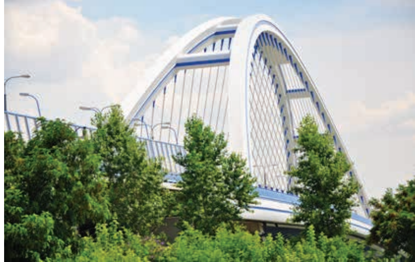
Stalowy most łukowy Apollo przez Dunaj w Bratisławie (obiekt nr 17)
