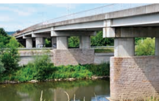
Wieloprzęsłowy most sprężony z belek wolnopodpartych przez Hron w Žarnovicy – w drodze do Nitry (obiekt nr 8)
