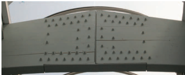
Rys. 2. Węzeł kalenicowy
