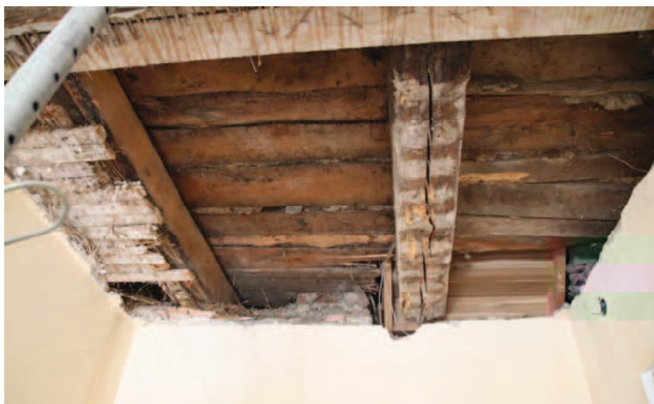
Rys. 6. Widok istniejącego stropu przed wzmocnieniem
