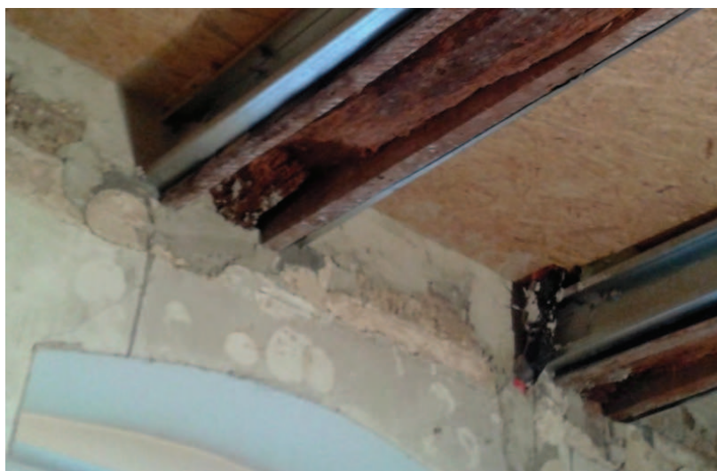
Rys. 10. Oparcie belek na murze
