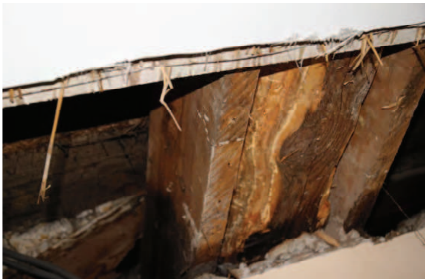
Rys. 8. Istniejące wzmocnienia belek w postaci bali drewnianych
