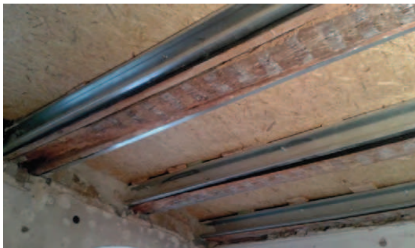
Rys. 9. Przyjęte rozwiązanie wzmocnienia stropu
