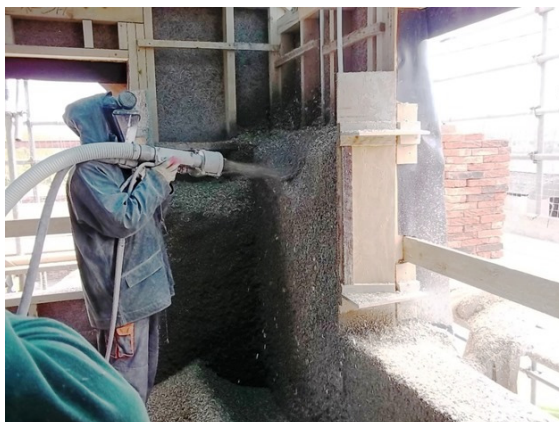
Rys. 7. Nakładanie mieszanki wapienno-konopnej metodą natrysku [ https://cannabisdigest.ca/building-future-hempcrete/ ]
