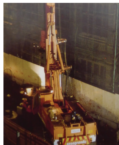
Rys. 2. Palownica Casagrande w trakcie nocnego wykonywania ściany palowej [6]
