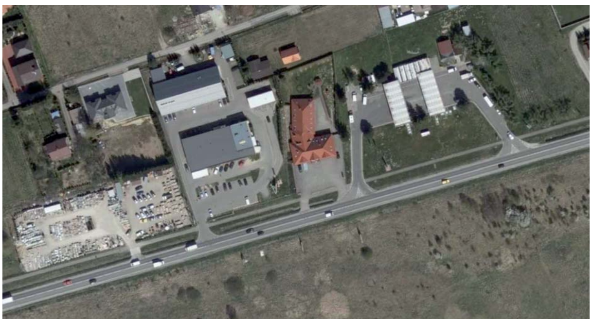
Fot. 4. Przykład zabudowanego otoczenia odcinka drogi GP bez pasów włączeń i wyląceń
