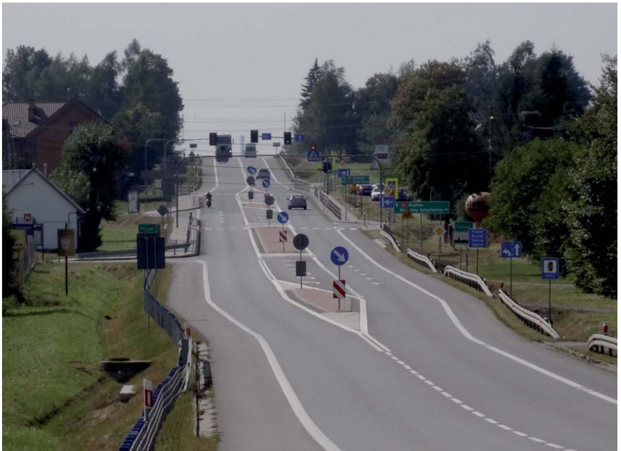
Fot. 6. Przykład dobrego zabezpieczenia zjazdów z drogi GP i wjazdów
