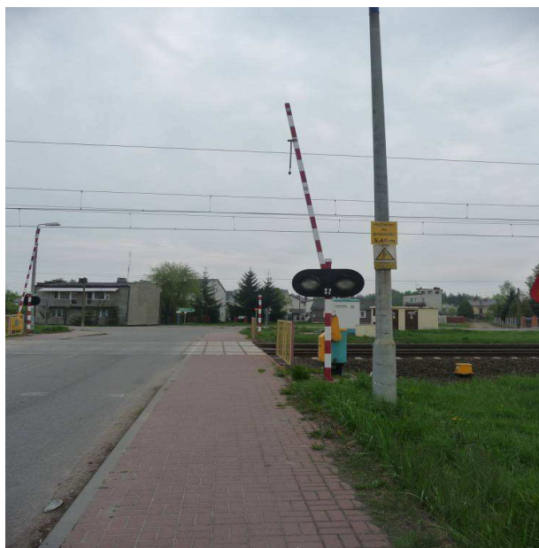
Rys. 5. Przejazd kat. B z urządzeniami SPA 4
