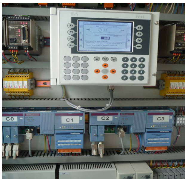
Rys. 4. Liniowe punkty sterowania samoczynnej blokady liniowej SHL-12
