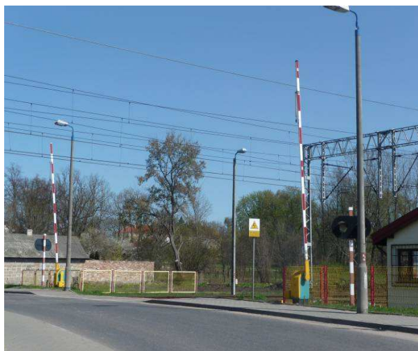
Rys. 6. Przejazd kat. A z urządzeniami SPR 2
