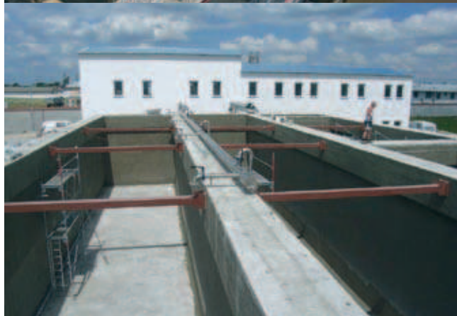
Rys. 11, 12. Ściany zbiornika w trakcie realizacji wzmocnienia i po jego wykonaniu
