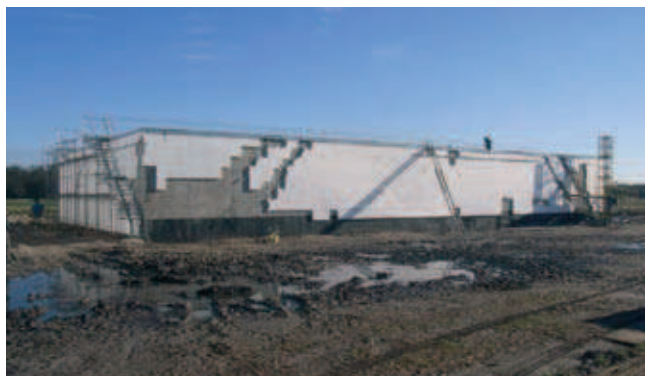
Rys. 2. Widok ogólny zbiornika przed jego wzmocnieniem
