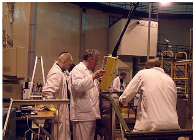
Rys. 5. Personel Zakładu Eksploatacji Reaktora MARIA transportuje blok grafitowy do komory demontażowej
