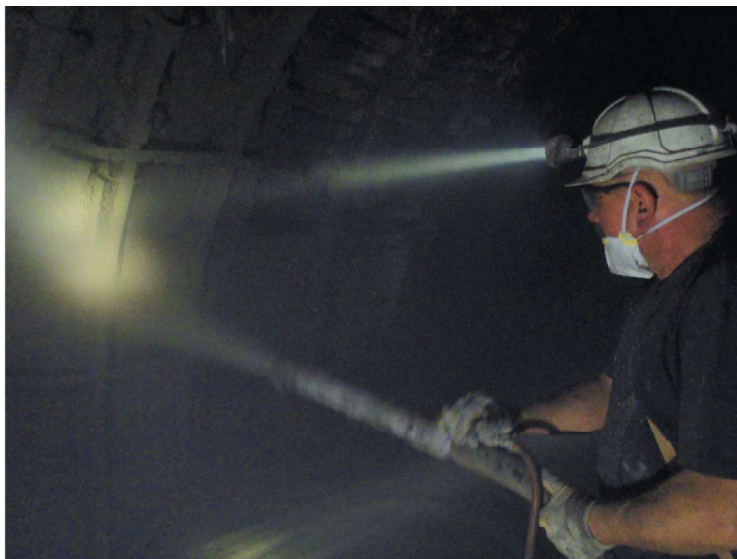
Rys. 5. Torkretowanie pierwszej warstwy torkretu: metoda sucha (materiał własny) Fig. 5. Shotcreting of the first layer of shotcrete using the dry method (own study)
