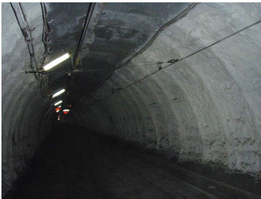
Rys. 6. Wyrobisko korytarzowe w obudowie ŁP po wzmocnieniu warstwą betonu natryskowego (materiał własny) Fig. 6. The steel arch support lined gallery after strengthening with a layer of shotcrete (own study)
