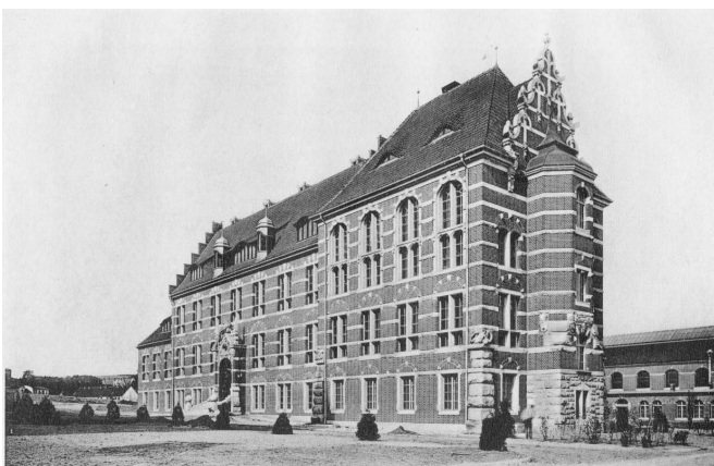
Rys.1. Budynek Instytutu Elektrotechnicznego, 1904 (zbiory Sekcji Historycznej PG)
