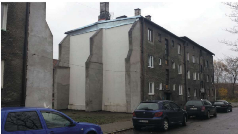
Rys. 2. Południowa elewacja budynku dwusegmentowego wraz z widokiem na dylatację Fig. 2. The southern elevation of the building along with the view of the dilatation
