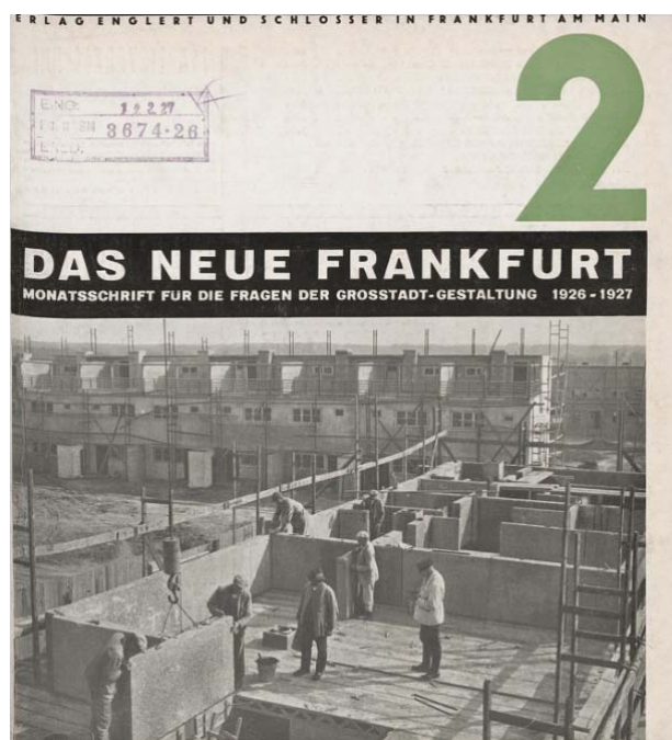
Il. 8. System Maya wykorzystujący żelbetowe panele w siedlung Praunheim, 1926. Okładka drugiego numeru Das Neue Frankfurt . Źródło: Das Neue Frankfurt
