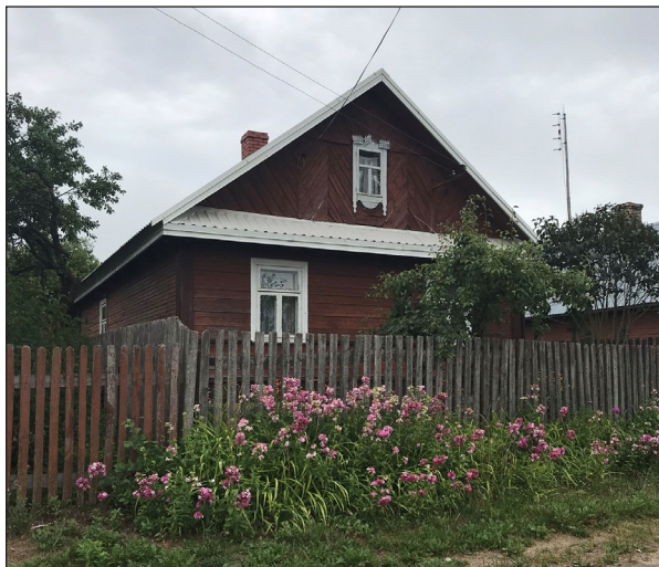
Fot. 3. Zachowane deskowanie domu w Białkach (fot. J. Wlazło) Photo 3. Preserved weatherboarding on a house in Białki (photo by J. Wlazło)
