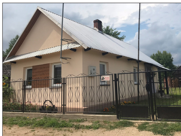
Fot. 6. Nowa stolarka okienna i tynk – obiekt w miejscowości Lachy (fot. J. Wlazło)
