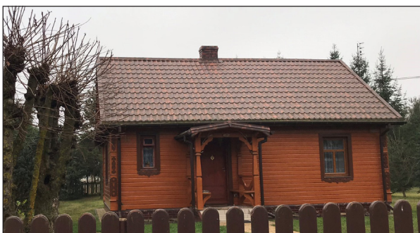
Fot. 4. Nowe szalowanie domu w Bruszkowszczyźnie (fot. J. Wlazło) Photo 4. New weatherboarding on a house in Bruszkowszczyzna (photo by J. Wlazło)
