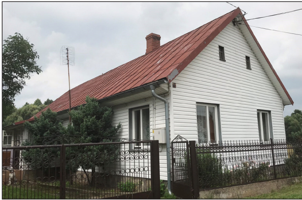
Fot. 1. Budynek kryty sidingiem, bez tradycyjnych detali architektonicznych (Janowo) (fot. J. Wlazło)
