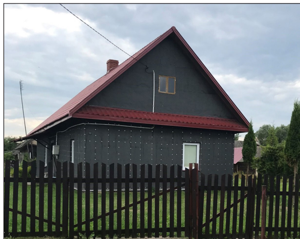
Fot. 5. Zmiana pokrycia elewacji i konstrukcji dachu w Waśkach (fot. J. Wlazło)
