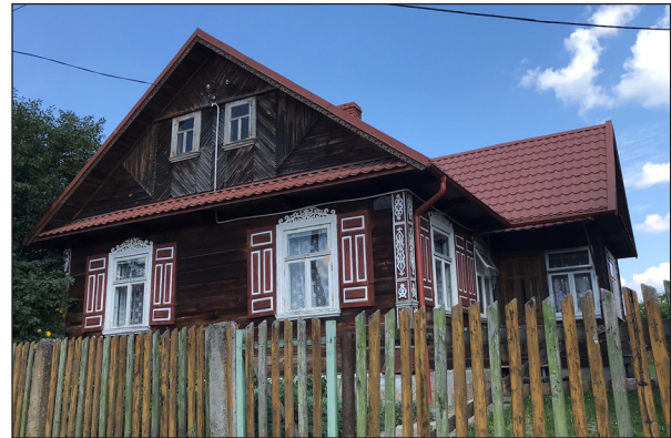
Fot. 2. Budynek z zachowanymi zdobieniami elewacji (Soce) (fot. J. Wlazło)
