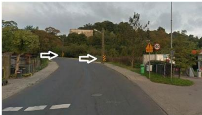
Rys. 11. Zbyt wąski wjazd na ulicy Strzałkowskiej [zdjęcie: autorzy]
