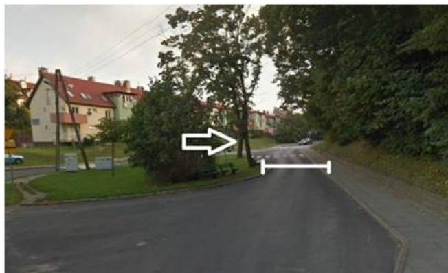
Rys. 12. Rozjazd na końcu drogi przy ulicy Strzałkowskiej [zdjęcie: autorzy]
