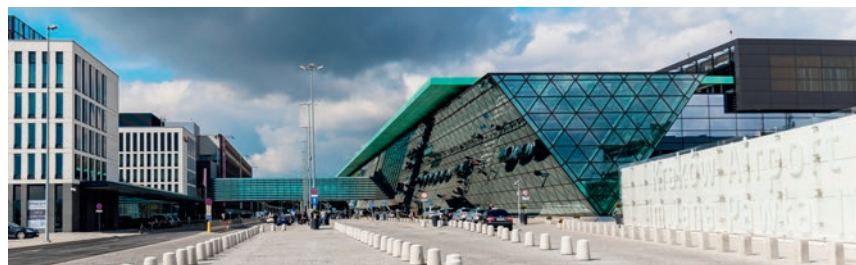
Ulica kpt. Mieczysława Medweckiego. Wnętrze o charakterze miejskiej zabudowy uformowane pierzejami terminalu T4, garażu wielopoziomowego i hotelu. Perspektywę zamyka kładka – przejście ponad układem komunikacyjnym łączące stację kolejową, garaż hotel i terminal, 2015. Autorzy terminalu T4, kładki, garażu wielopoziomowego, koncepcji WUK: Jacek Czech, Janusz Duliński, Piotr Wróbel. Projekt hotelu: PRC Architekci. Fot. Piotr Osak, archiwum biura APA
