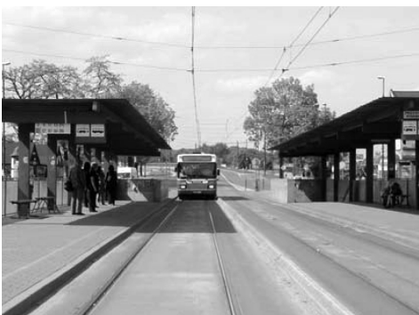
Fot. 8. Przykład zastosowania wyniesionego separatora na ul. Na Zjeździe
