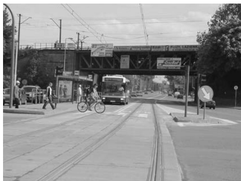
Fot. 1. Przykład zintegrowanego przystanku autobusowo-tramwajowego przy ul. Wielickiej
