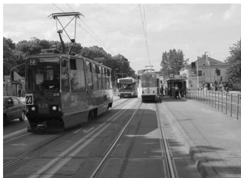
Fot. 2. Przykład zintegrowanego przystanku autobusowo-tramwajowego przy ul. Wielickiej
