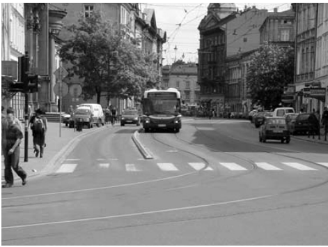
Fot. 6. Przykład zastosowania wyniesionego separatora na ul. Stradom
