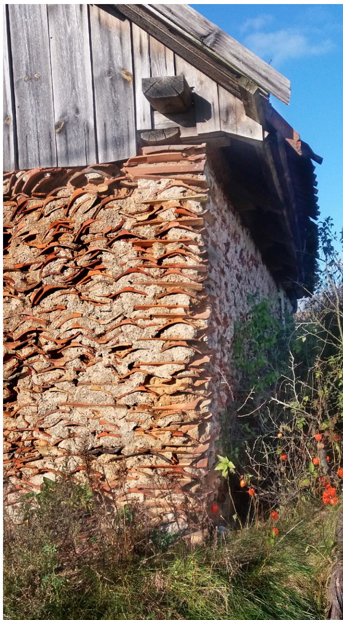
Ryc. 1. Jeden z budynków o ścianach z dachówek w Czarnej Wsi Kościelnej; fot. J. Ciecuch i P. Gołębiowski, 2016
