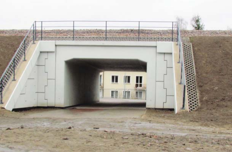
Rewitalizowana linia kolejowa Gdynia Gł.-Gdańsk Osowa będąca przyszłym fragmentem Pomorskiej Kolei Metropolitalnej: odcinek Gdańsk Strzyża-Gdańsk Brętowo, wiadukt nad ulicą Kiepury (8.12.2014 r.). Fot. R. Stankiewicz
