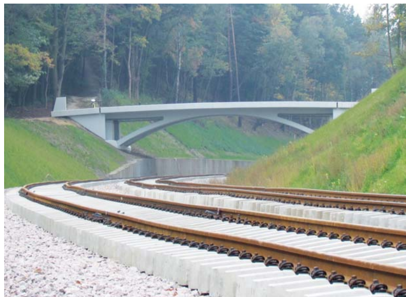
Rewitalizowana linia kolejowa Gdynia Gł.–Gdańsk Osowa będąca przyszłym fragmentem Pomorskiej Kolei Metropolitalnej; odcinek Gdańsk Strzyża–Gdańsk Brętowo, wiadukt w ciągu drogi leśnej (ul. Ludowa) (9.10.2014 r.). Fot. R. Stankiewicz
